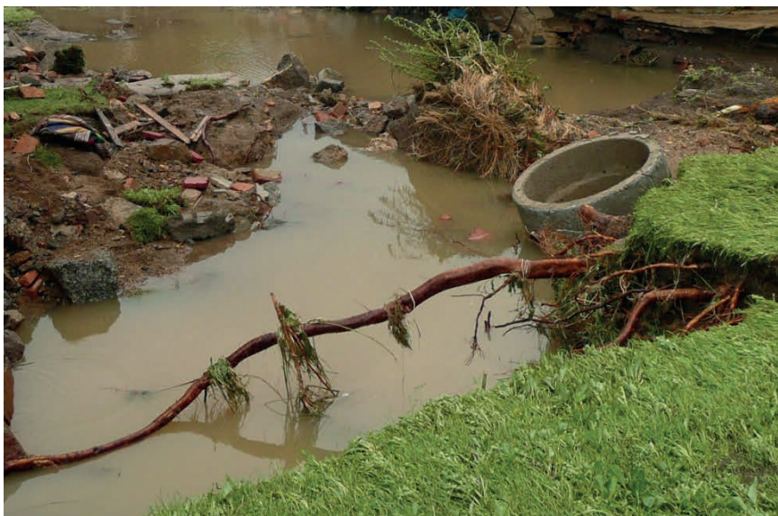
Obrázek č. 24 Následky bleskové povodně (zdroj:www.hzscr.cz)
